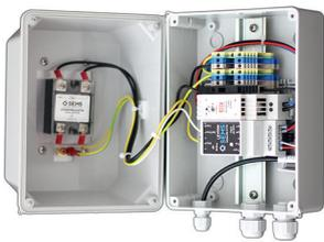
Warmwasseraufbereitung für 1-phasigen Heizstab
